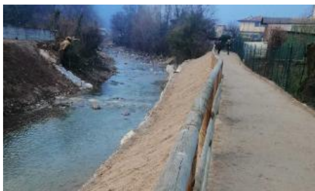
Il nuovo aspetto della pista ciclabile e dell'argine del Mella a Sarezzo
